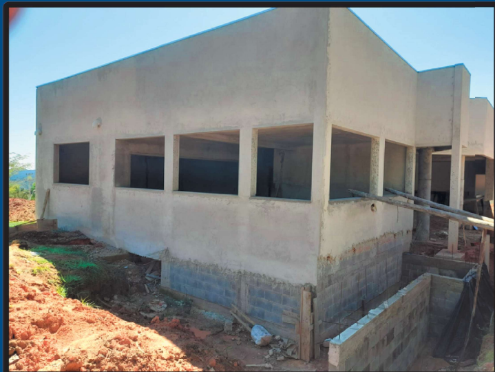
Construção da Escola Municipal Especial Doraci - Três Corregos
