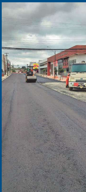
Obra Rua Ver. Arlindo Chemin
