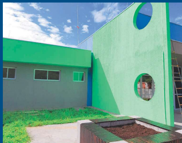
Obra da UBS Botiatuva
