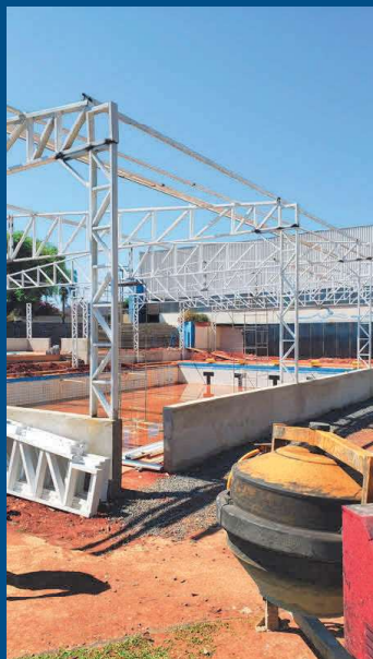
Obra da Vila Olímpica
