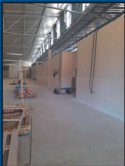
Construção da Escola Municipal Anderson Paulart JR - Legrand
